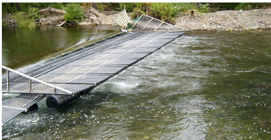
Рис. 3.2.2. Временное рыболовное заграждение ЛРЗ «Озерки» (р. Плотникова, Камчатка)
